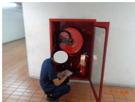
ภาพที่ 2.2-26 การตรวจสอบอุปกรณ์ดับเพลิง
